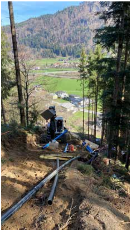
Mit viel Mühe wurden die Rohre für den neuen Hochbehälter mit Hilfe von Spezialmaschinen am Steilhang verlegt. Der Leitungsbau wurde im Frühjahr abgeschlossen.
