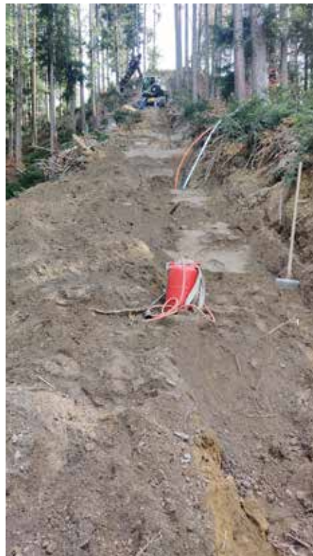
Mit viel Mühe wurden die Rohre für den neuen Hochbehälter mit Hilfe von Spezialmaschinen am Steilhang verlegt. Der Leitungsbau wurde im Frühjahr abgeschlossen.
