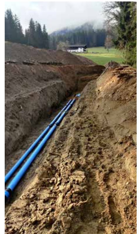
Mit viel Mühe wurden die Rohre für den neuen Hochbehälter mit Hilfe von Spezialmaschinen am Steilhang verlegt. Der Leitungsbau wurde im Frühjahr abgeschlossen.
